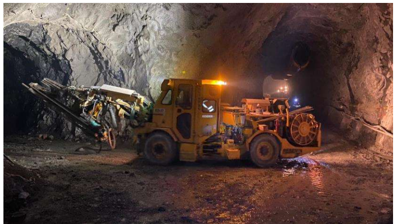
Figura 6 – Escavação Subterrânea nas obras de Aripuanã
