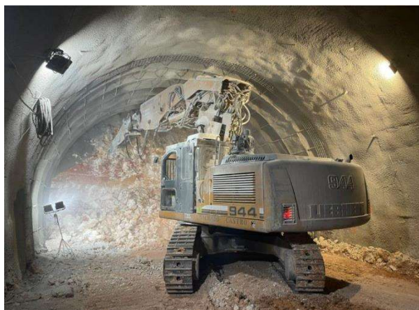
Figura 7 – Escavação do Túnel do Metrô de Lisboa
