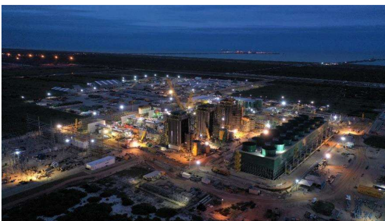
Figura 1 - Termoelétrica GNA I
