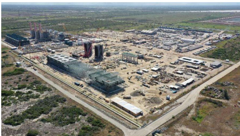
Figura 2 – Termoelétrica GNA II em construção
