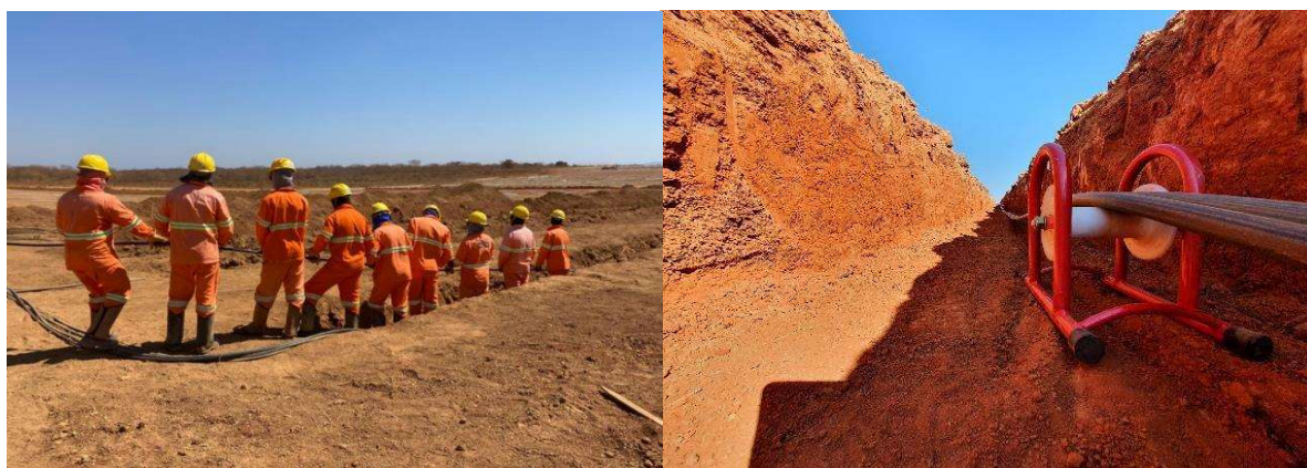
Figura 4 – Antes e depois da automação de Lançamento de cabos em Janaúba
