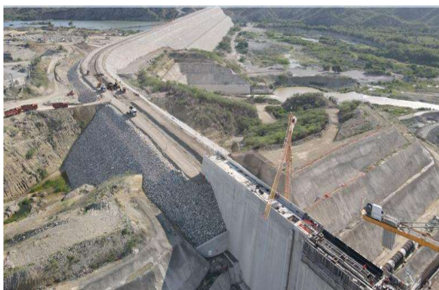
Figura 8 - Construção da Barragem de Montegrande
