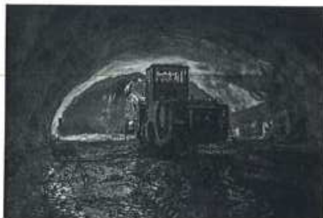
Maquinaria trabajando en una de las Autopistas que OHLA ha desarrollado en Chile.
