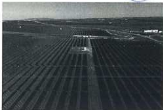
Planta fotovoltaica desarrollada por OHLA en España.
