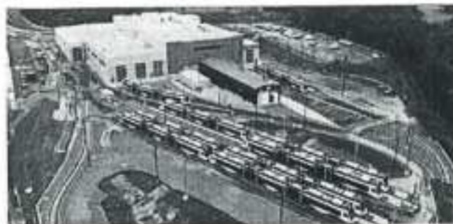
La llegada de los 28 vehículos de tren ligero a las instalaciones de operaciones y mantenimiento de la Purple Line, semanas antes de lo previsto, representa un hito clave en el avance del proyecto.
