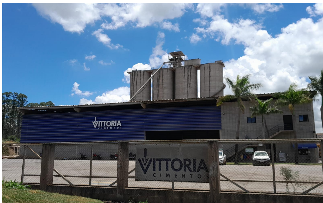
Vista de Entrada da Vittoria Cimentos S/A
