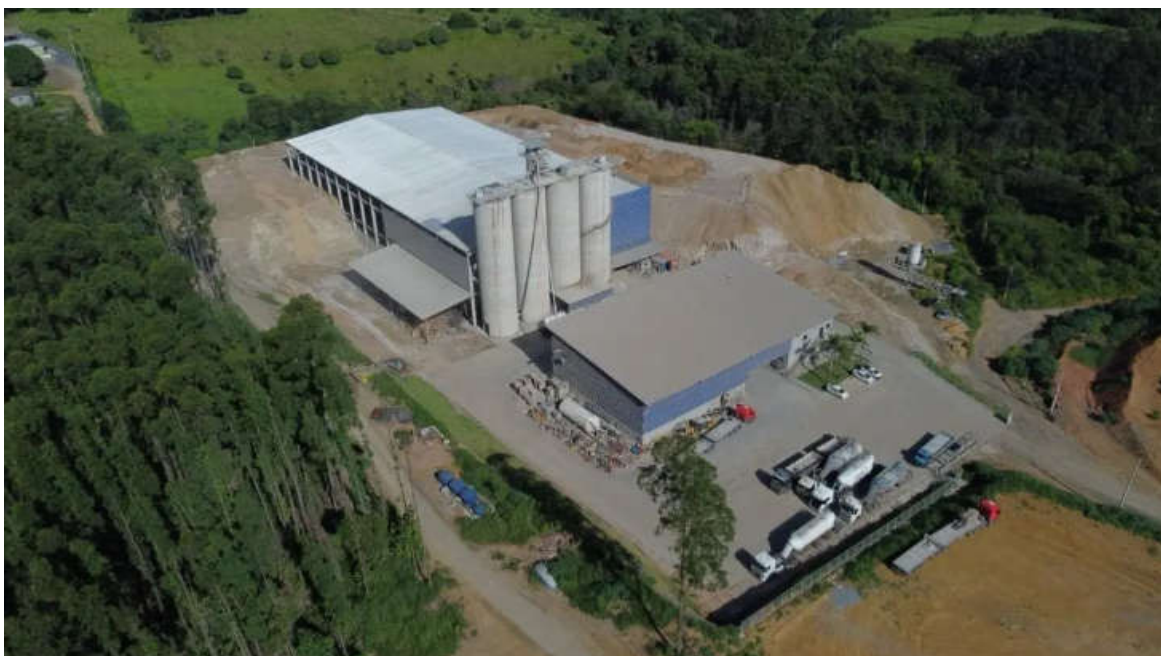
Vista de Aérea da Vittoria Cimentos S/A – Acionista da LIGA S.A. (Sede da Sociedade)
