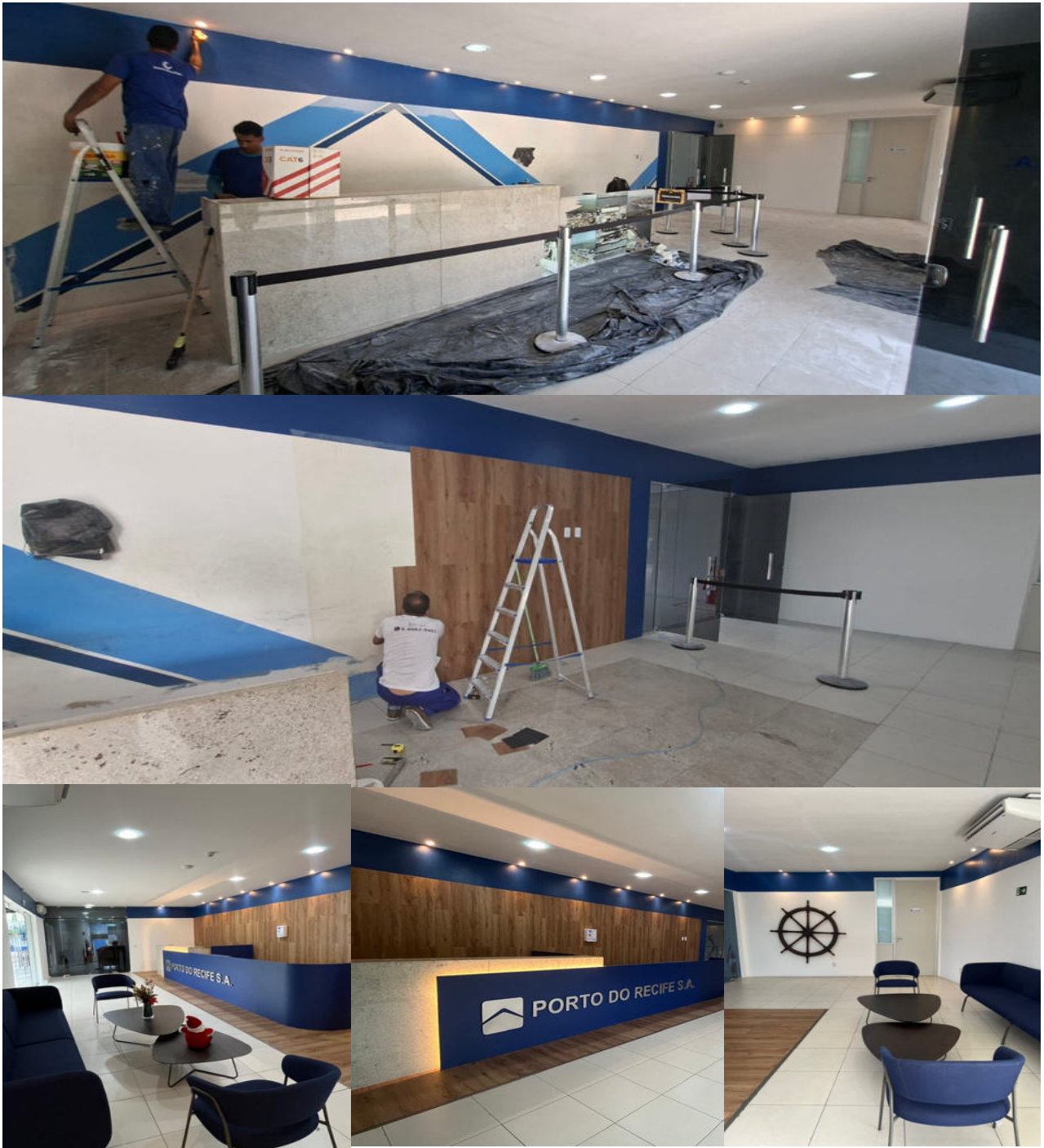
Obra finalizada Fonte: Porto do Recife
