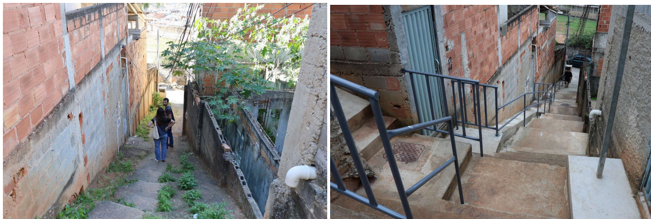
Antes e depois de obra do escadão - Rua 2, Milho Branco
