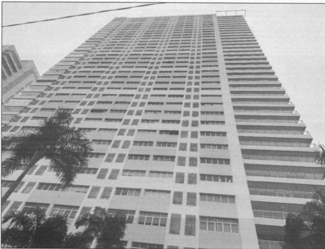
Prédio onde localiza-se o imóvel objeto.
