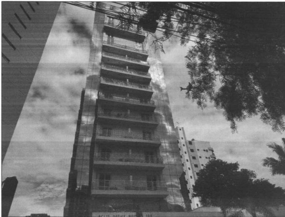
Prédio onde localiza-se o imóvel objeto.
