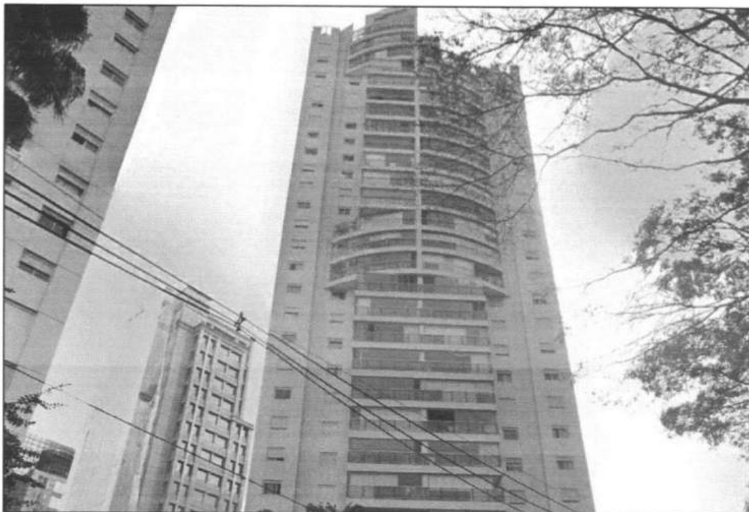
Prédio onde localiza-se o imóvel objeto.
