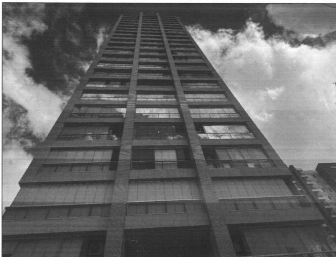
Prédio onde localiza-se o imóvel objeto.
