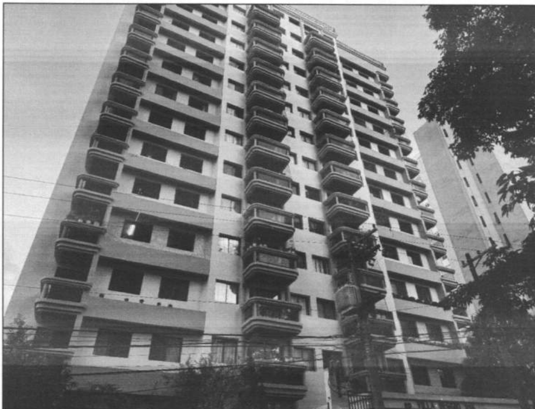
Prédio onde localiza-se o imóvel objeto.
