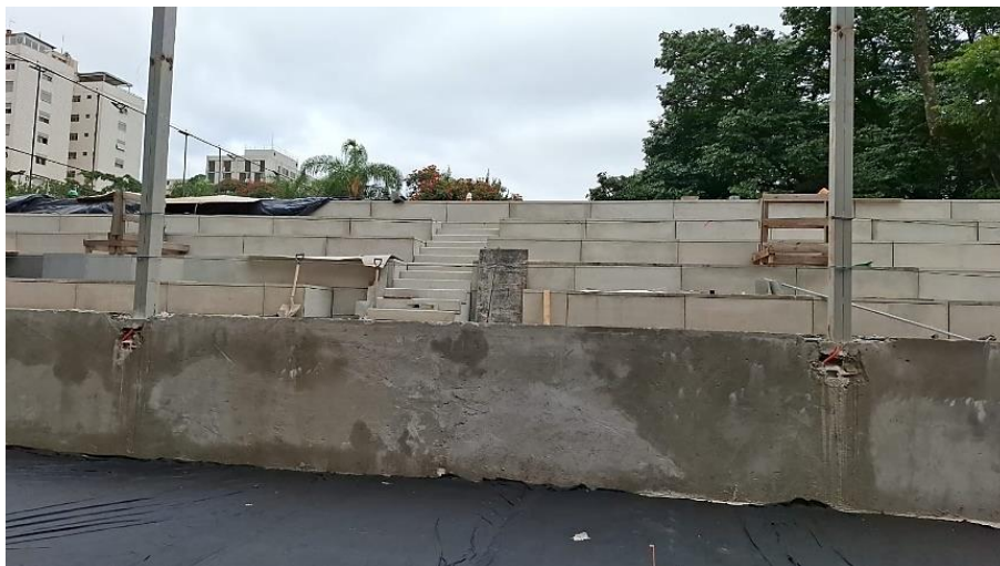
Foto 03: Evolução da Obra – Vista Parcial da Quadra Poliesportiva
