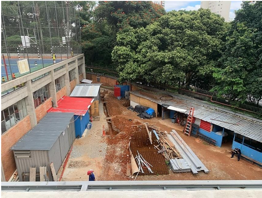
Foto 04: Evolução da Obra – Vista da Área de Convivência (Espaço Verde)
