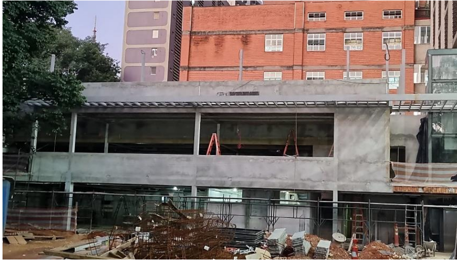
Foto 01: Evolução da Obra – Vista do Mezanino e do Térreo
