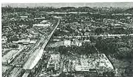
Estación Villa Zaita. Línea 1. Metro de Panamá.
