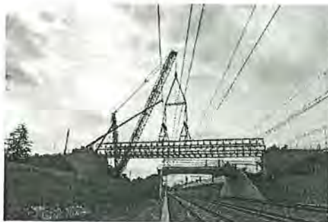
Retirada del puente de 150 toneladas en Åkarp, Suecia. Foto: Niclas Franzén, OHLA/NCC.
