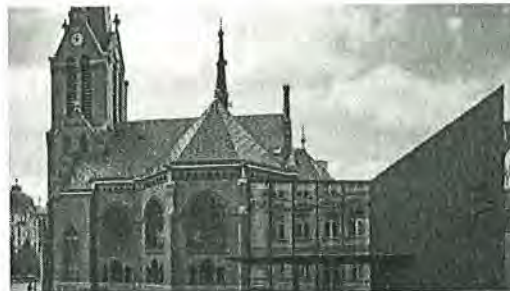
Biblioteca de Investigación de Olomouc (República Checa) Building of the Year 2023. Fundación para el Desarrollo de la Construcción y la Arquitectura.
