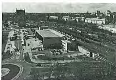
Estación de Havířov donde se llevarán a cabo actuaciones de modernización en las infraestructuras. República Checa.
