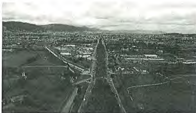
Proyecto Corredor Accesos Norte 2. Bogotá, Colombia.
