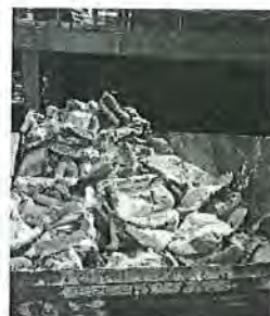
Recogida segregada de sacos en obra.
