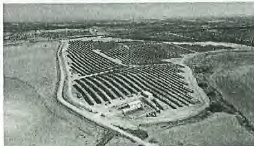
Planta fotovoltaica Olivares, 50MW. Jaén, España.
