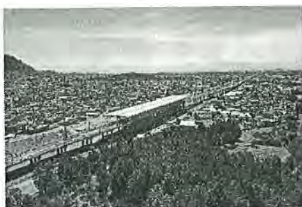
Tramo 1. Tren Interurbano México-Toluca. Estado de México, México.
