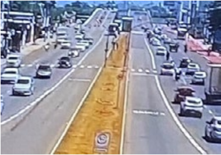
Trechos revitalizados da PE-15 já carecem de manutenção
