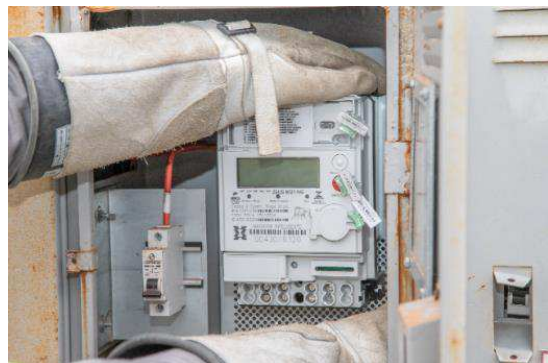
Foto: instalação de medidor
