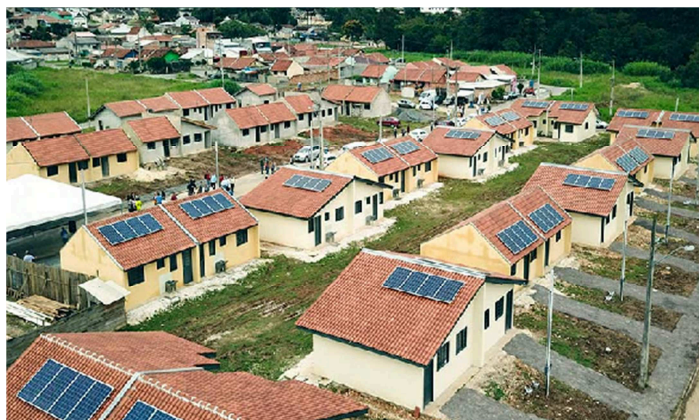
FIGURA Nº 05 - Conjunto habitacional Faxinal, no bairro Barreirinha entregue pela COHAB-CT em 2018 com 26 painéis fotovoltaicos
