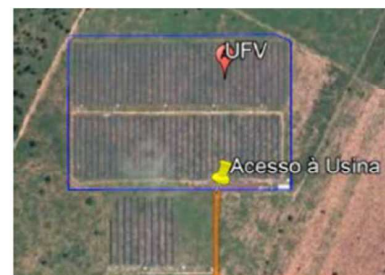
Localização da planta fotovoltaica
