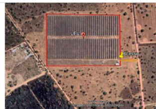
Localização da planta fotovoltaica
